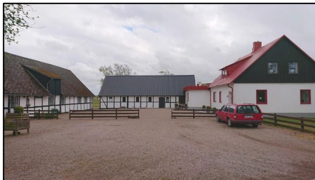
Görslöv stora 2 efter renoveringen 2020
